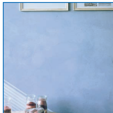
Le balayage des 2 couleurs de CHAMAREL finition permet le décor à aspect nuagé.
