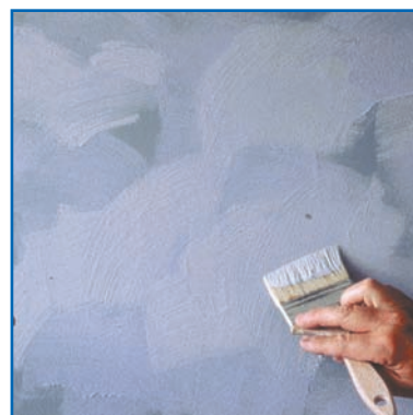
Application de la deuxième couche de CHAMAREL finition mouillée sur mouillée.
